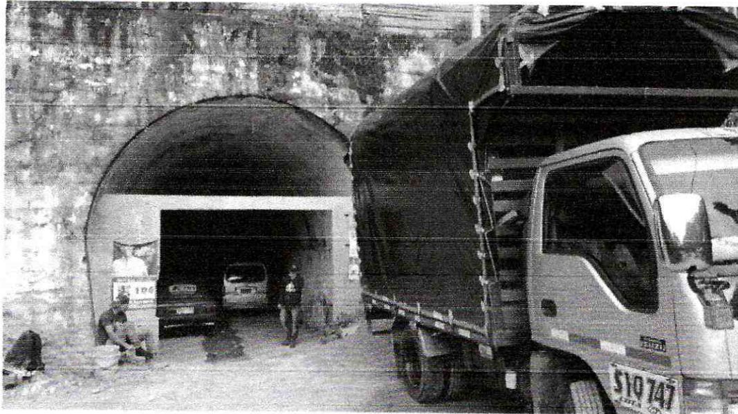
Túneles de boquerón
