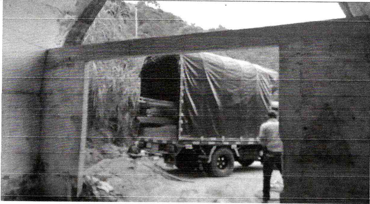
Túneles de boquerón
