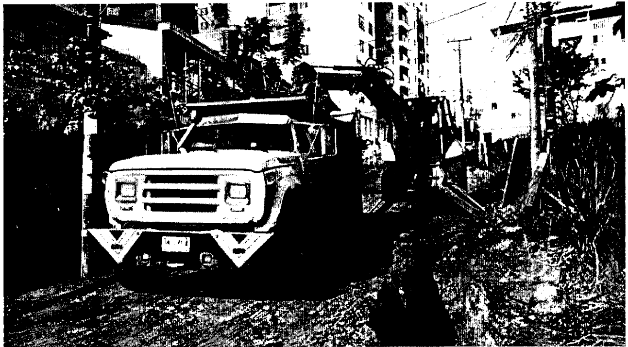
ESCOMBRE CALLE 57 CON 6
