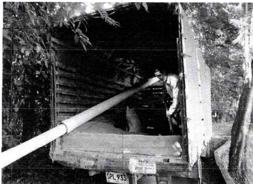
PLANTA DE AGUAS RESIDUALES
