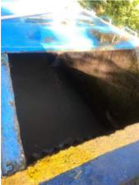
Fotografía 1 Entrada PTARD Tejar
