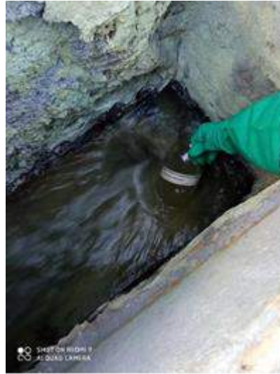
Fotografía 2 Toma directa para grasas y aceites en salida da PTARD
