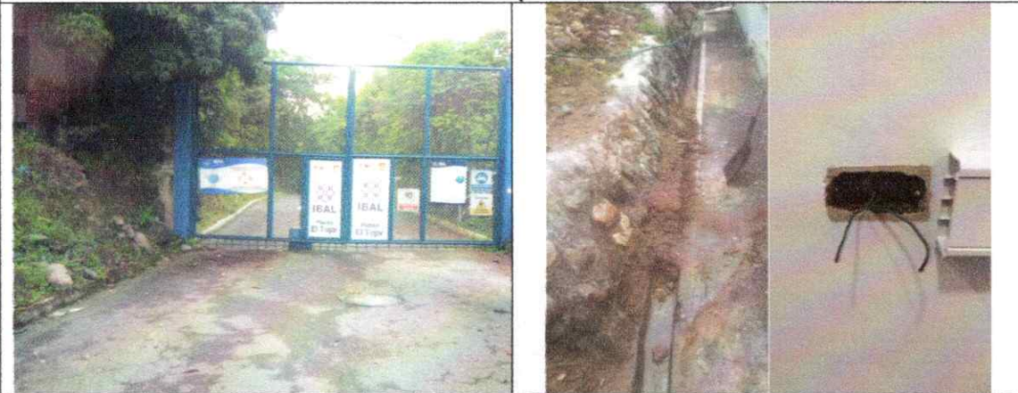
Adecuacion oficina de planta el tejar
