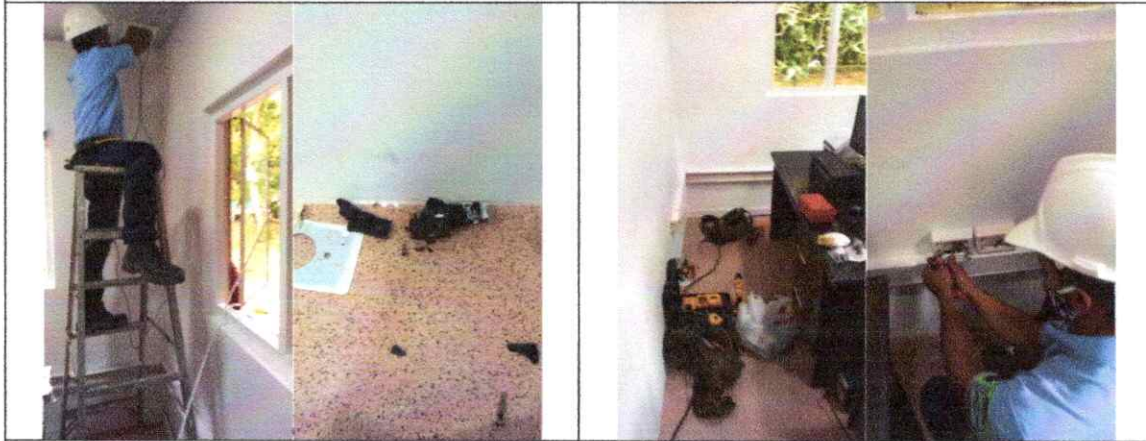
Adecuacion oficina de planta el tejar
