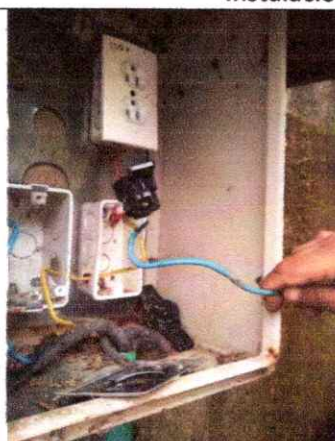
Reparación tablero de hidro lavadora
