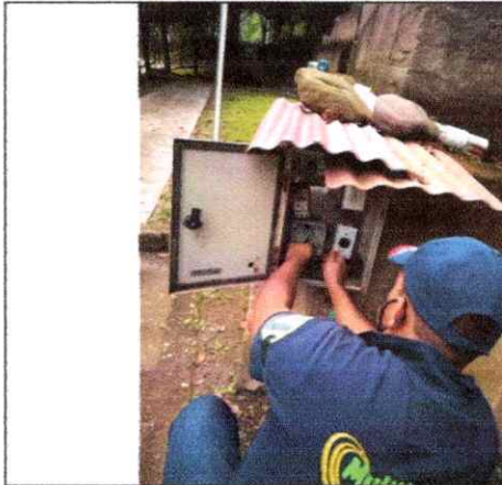
Reparación tablero de hidro lavadora
