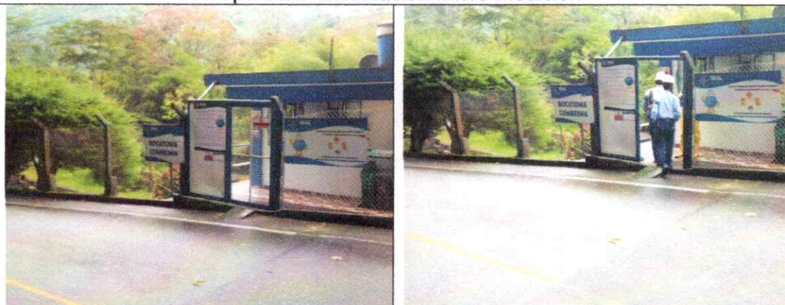
Revisión de planta eléctrica de bocatoma combeima
