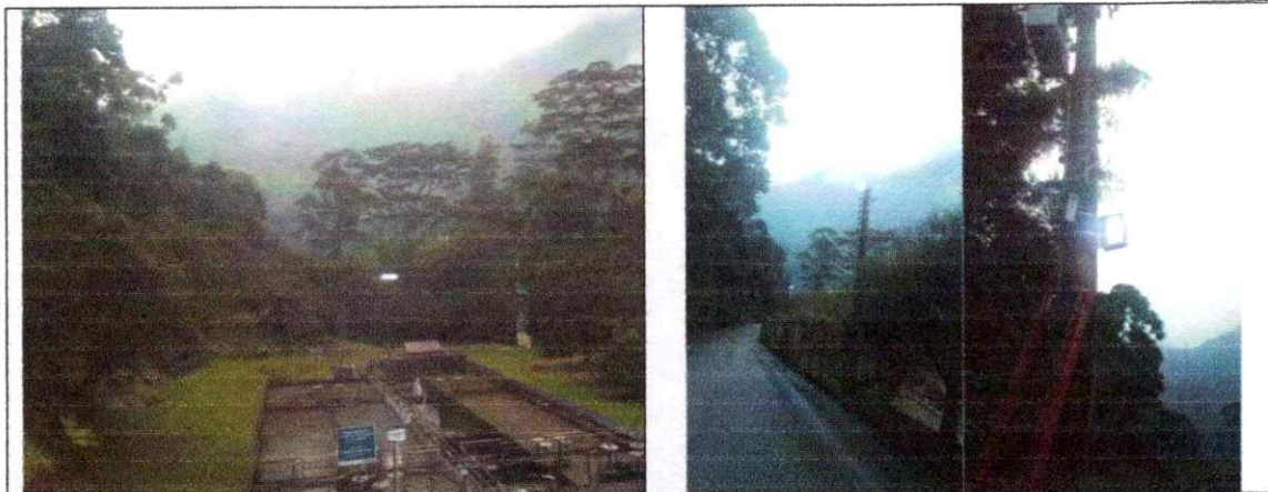
Revisión iluminación bocatoma combeima
