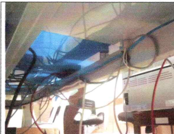
Instalación punto de red oficina de talento humano
