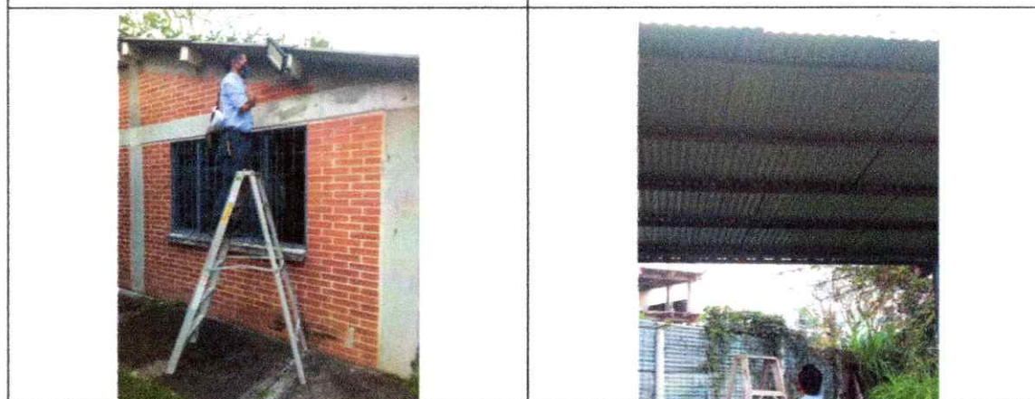
Cambio de iluminación de tanque piederapintada
