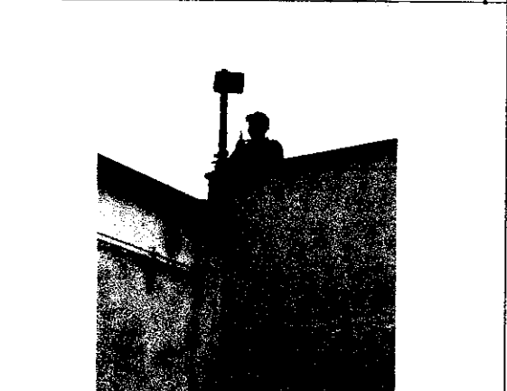
instalación iluminación P. Pintada
