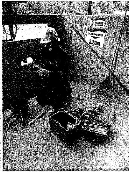
Foto N° 14. Mediciones In Situ Captación Combeima
