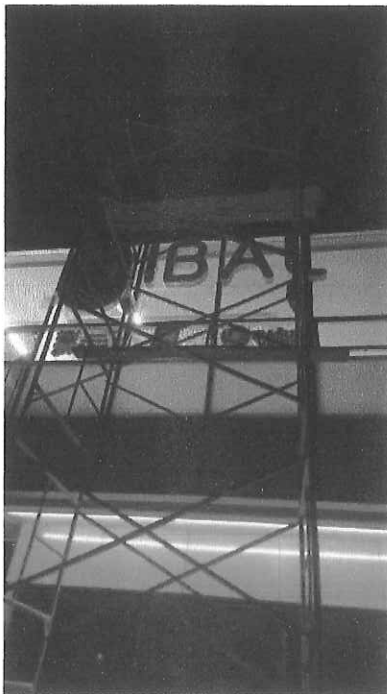
Instalación logo luminoso exterior
