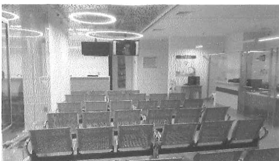
Desmante e instalacion carteleras
