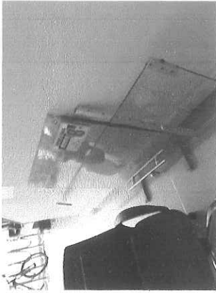
Montaje de cabinas en vidrio
