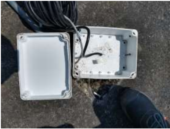
Antes del mantenimiento
