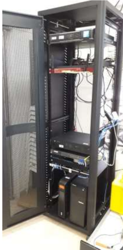
Despues de mantenimiento a PC1, PC2, UPS, SWICH
