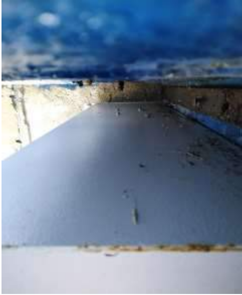
Antes del mantenimiento
