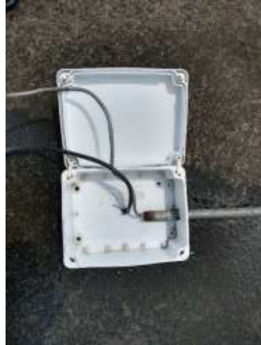
Después del mantenimiento
