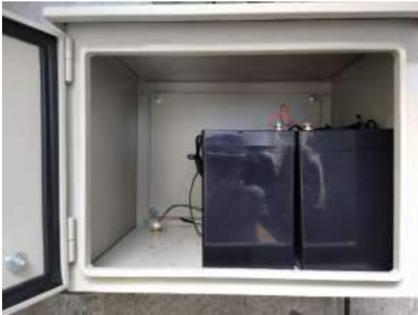
Antes del mantenimiento
