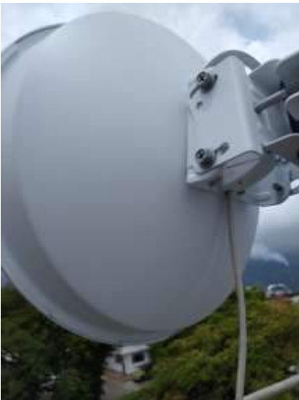
Antes del mantenimiento
