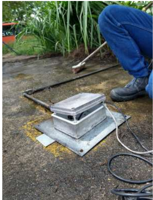
Después de mantenimiento
