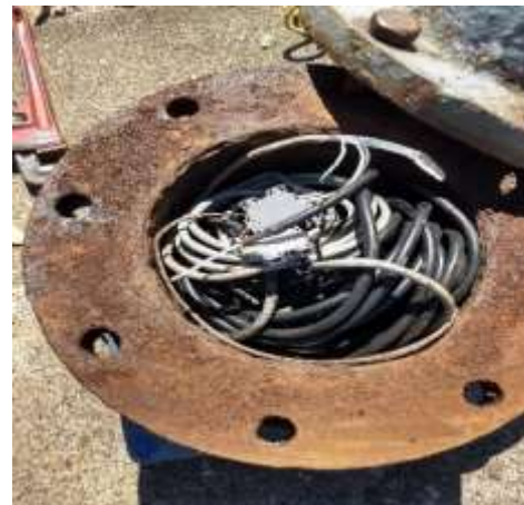
Después de mantenimiento
