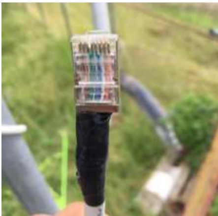
Estado de los terminales RJ45 en el cableado de datos
