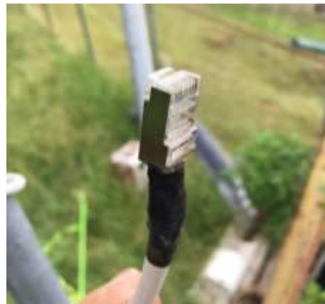
Estado de los terminales RJ45 en el cableado de datos
