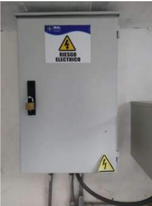
Antes del mantenimiento
