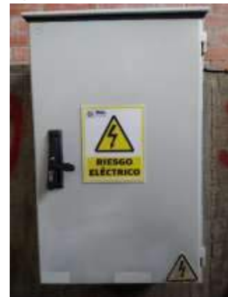
Después del mantenimiento
