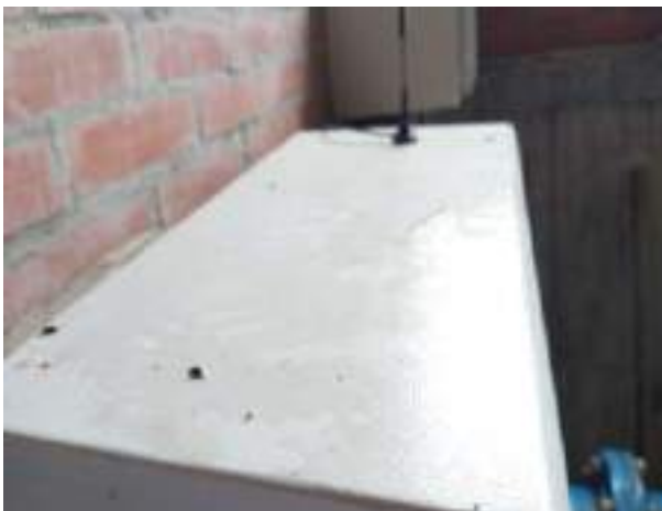
Antes del mantenimiento
