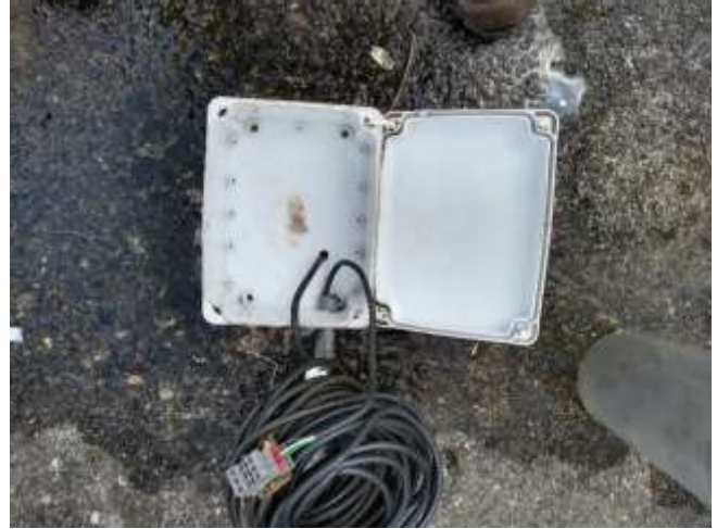
Después del mantenimiento
