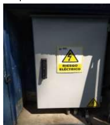
Después del mantenimiento
