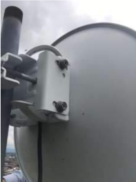
Antes del mantenimiento
