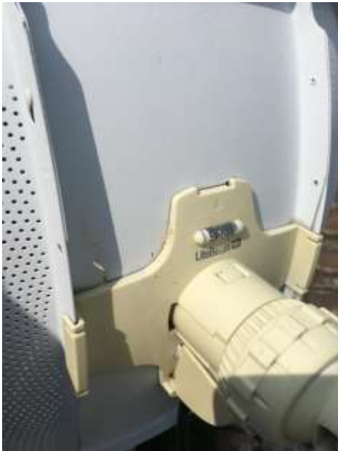
Antes del mantenimiento
