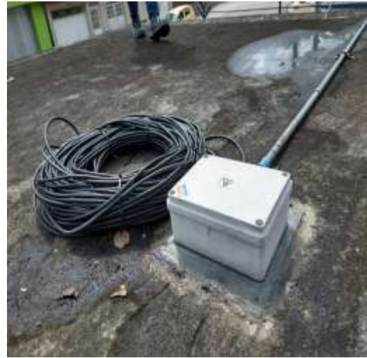
Después de mantenimiento
