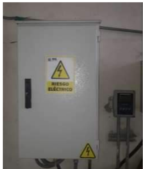
Después del mantenimiento
