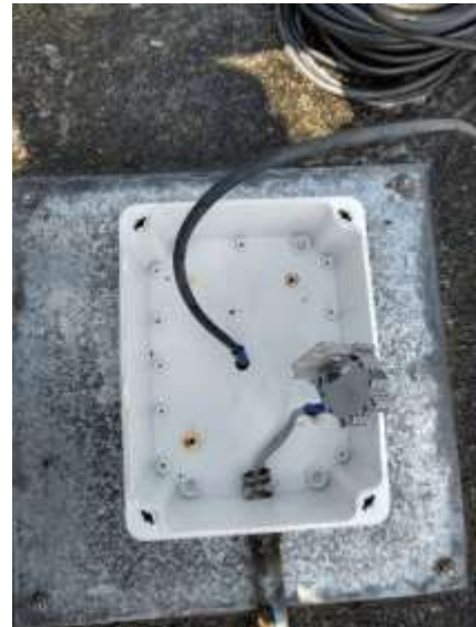
Después del mantenimiento
