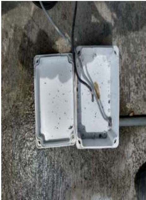
Antes del mantenimiento
