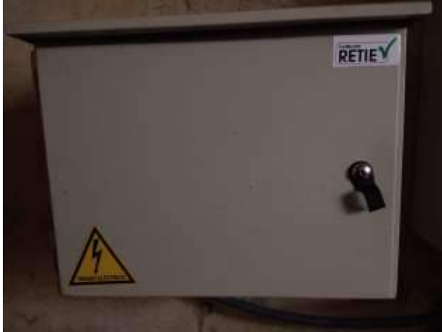
Antes del mantenimiento
