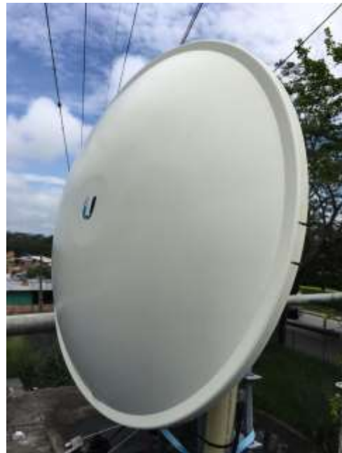
Después del mantenimiento
