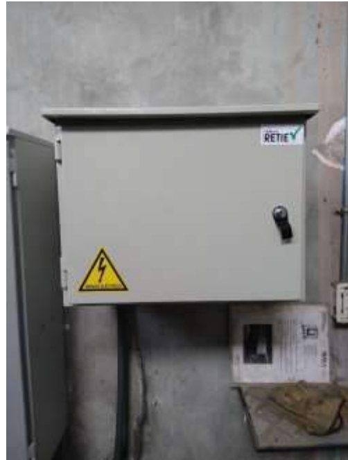
Después del mantenimiento
