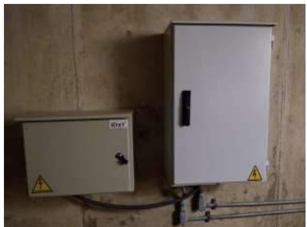
Después del mantenimiento
