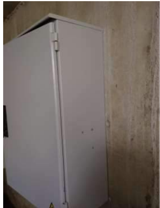
Después del mantenimiento
