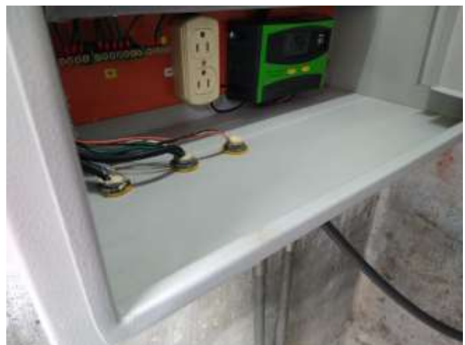
Después del mantenimiento
