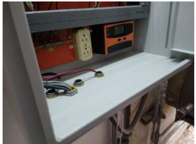
Después del mantenimiento
