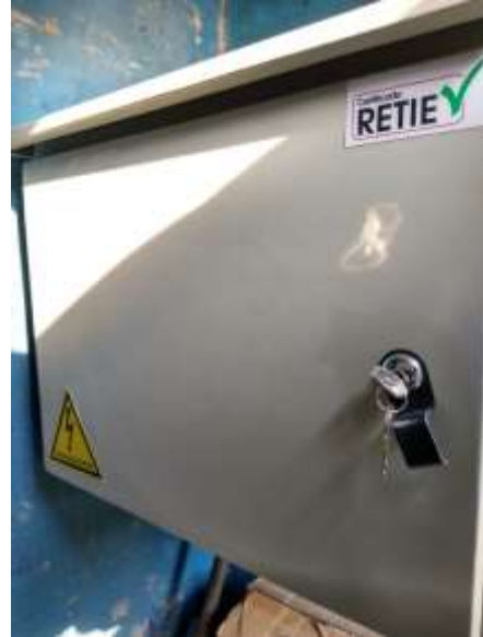
Después del mantenimiento
