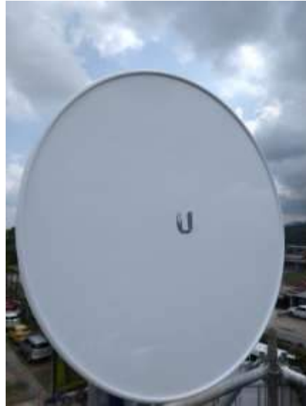
Después del mantenimiento
