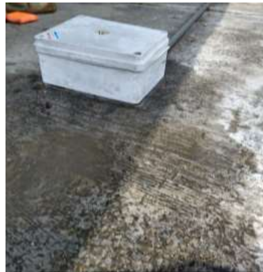
Después de mantenimiento
