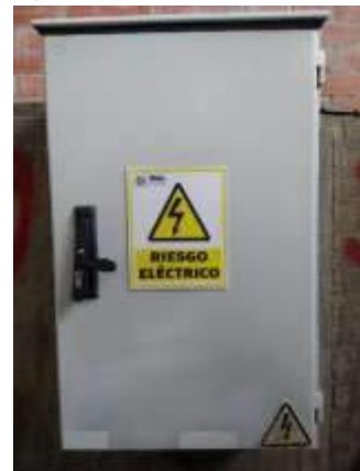
Después del mantenimiento
