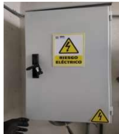
Después del mantenimiento
