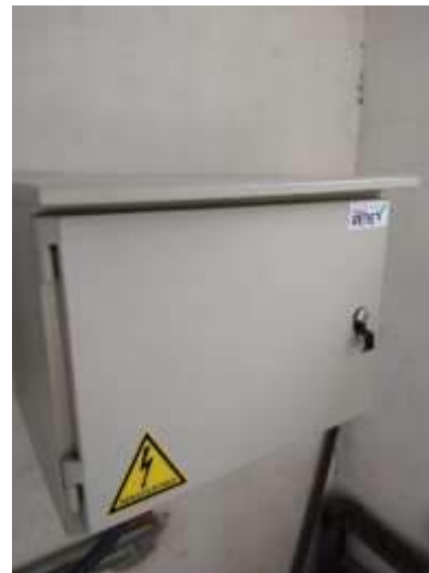
Después del mantenimiento
