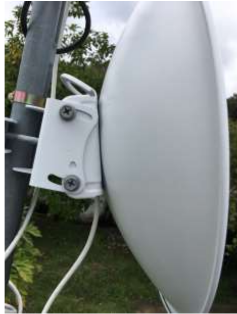
Después del mantenimiento
