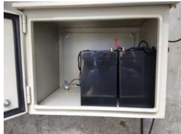
Después del mantenimiento
