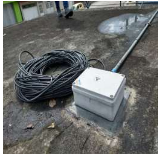
Después de mantenimiento
