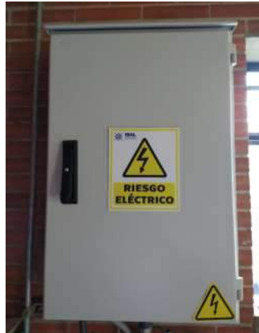
Después del mantenimiento
