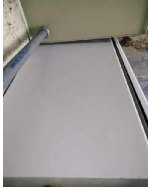
Después del mantenimiento
