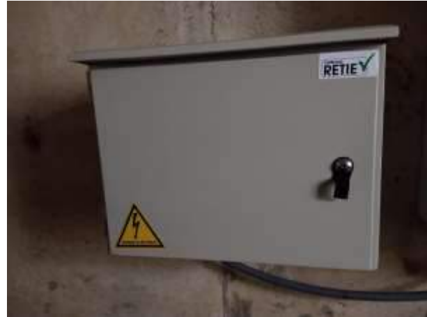
Después del mantenimiento
