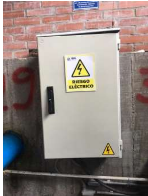
Después del mantenimiento
