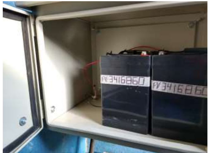
Después del mantenimiento
