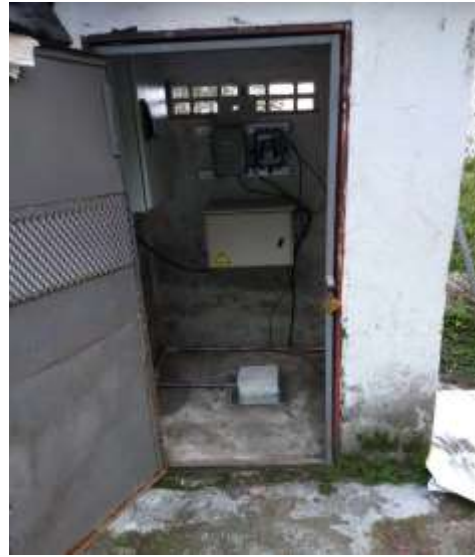
Después de mantenimiento
