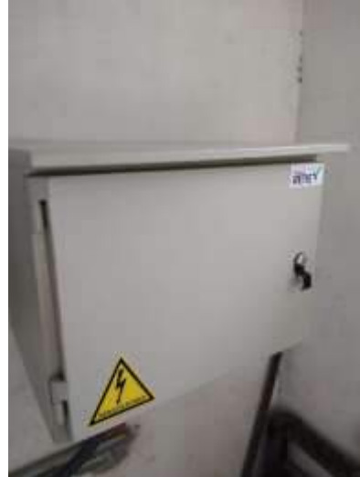
Después del mantenimiento
