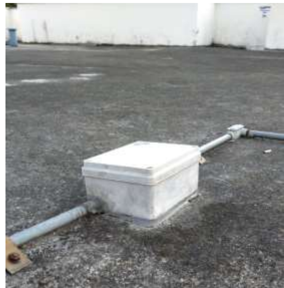
Después de mantenimiento
