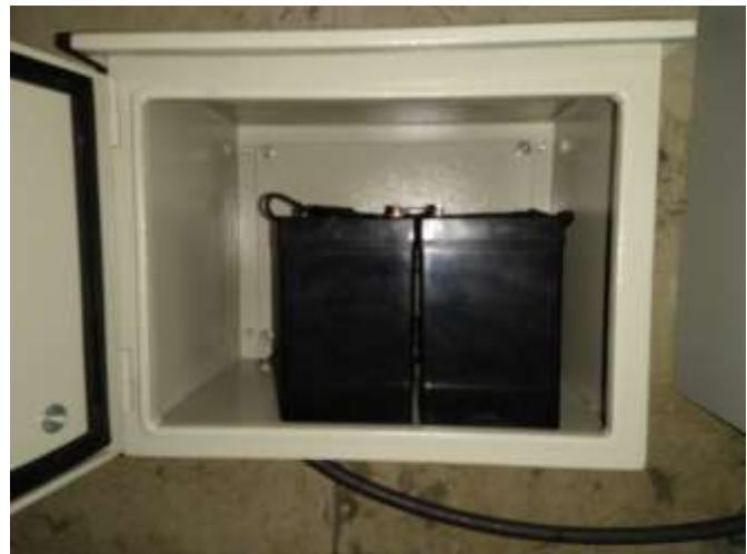
Después del mantenimiento
