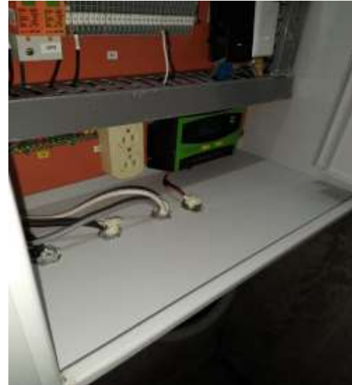
Después del mantenimiento
