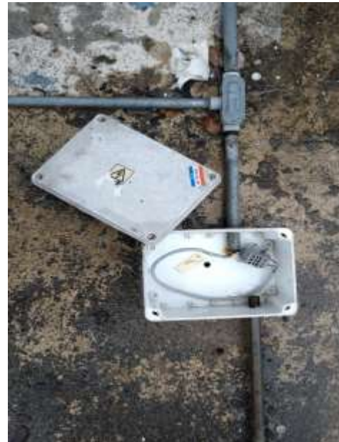
Después del mantenimiento
