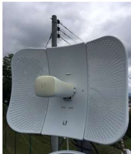
Después del mantenimiento
