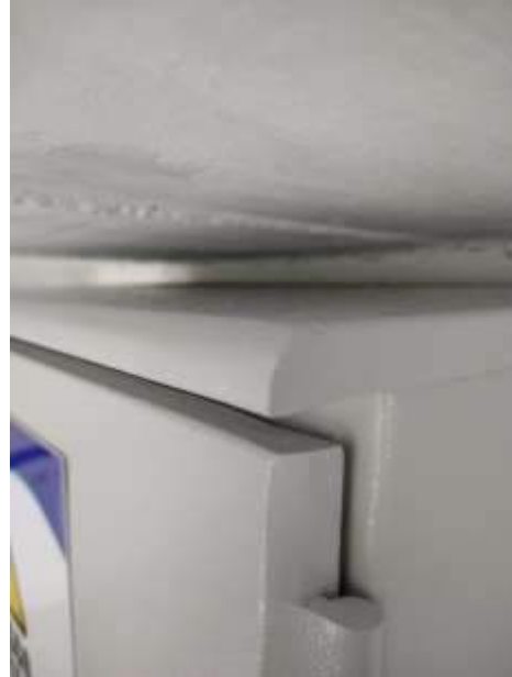
Después del mantenimiento
