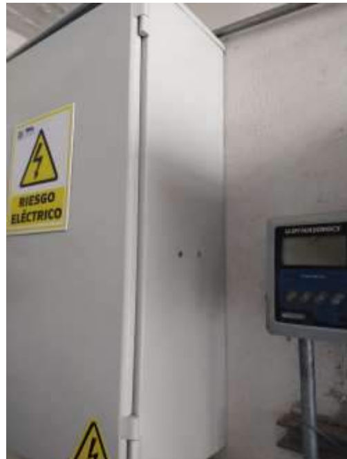
Después del mantenimiento
