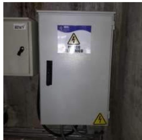
Después del mantenimiento
