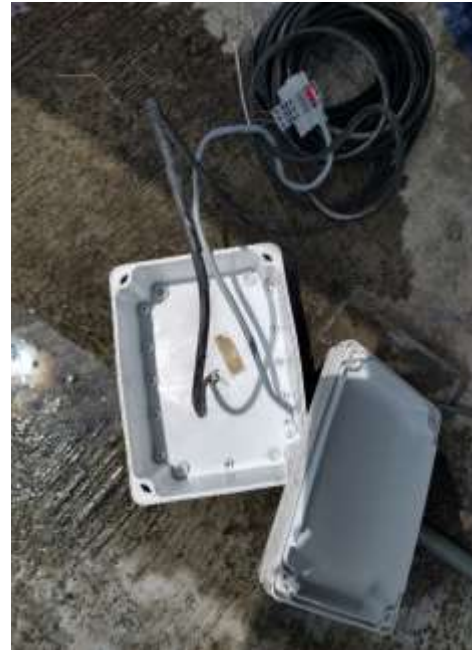
Después del mantenimiento
