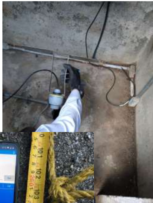
Después del mantenimiento
