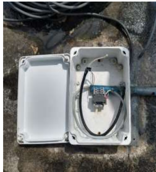
Después del mantenimiento
