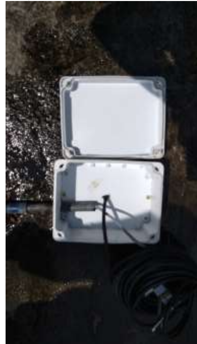
Después del mantenimiento
