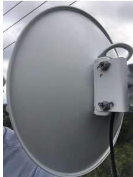
Después del mantenimiento
