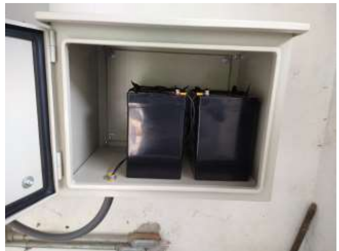
Después del mantenimiento
