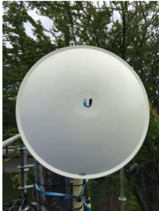
Después del mantenimiento
