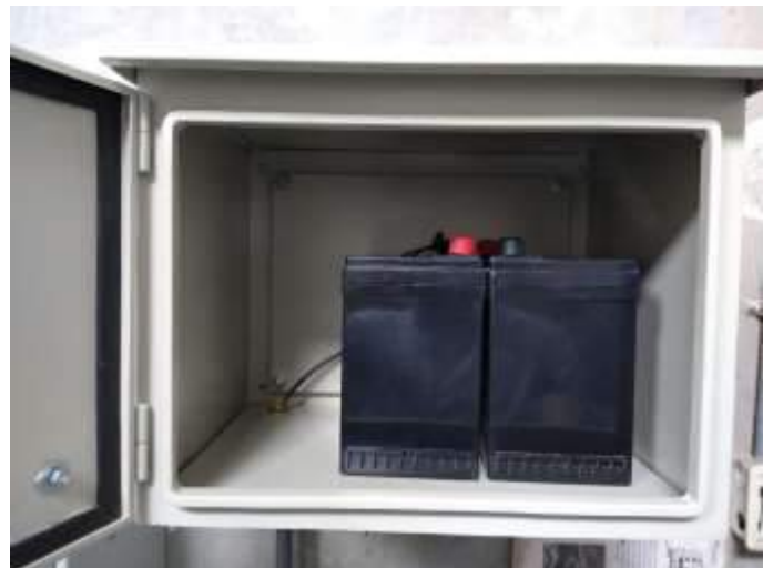
Después del mantenimiento
