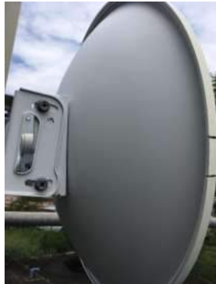
Después del mantenimiento
