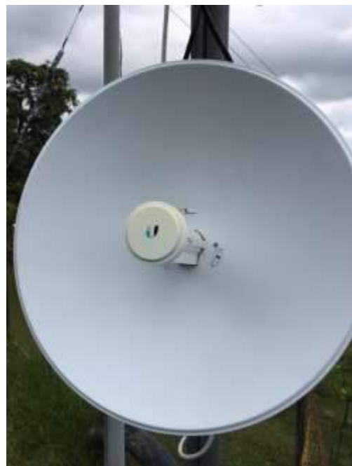
Después del mantenimiento
