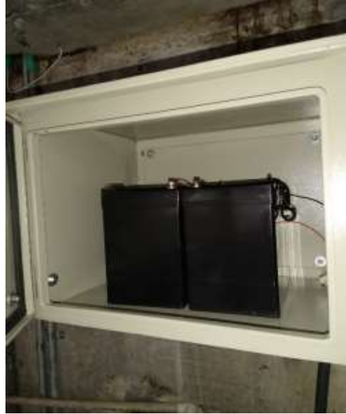
Después del mantenimiento
