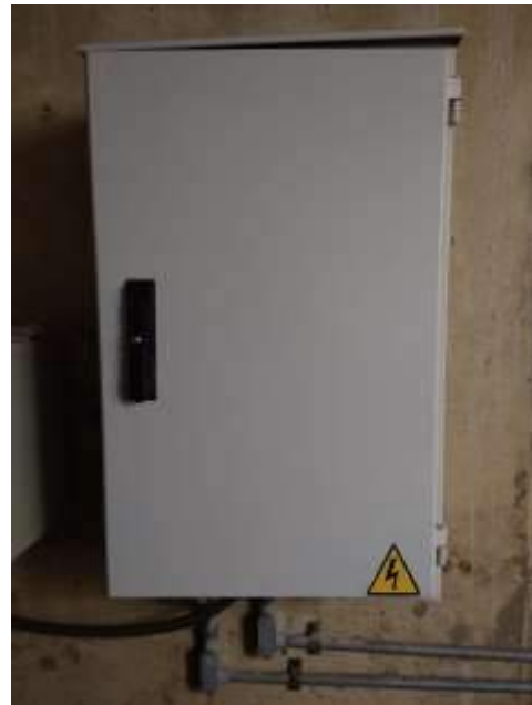
Después del mantenimiento
