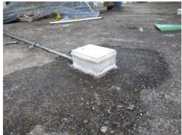
Después de mantenimiento
