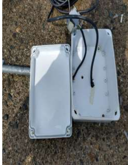
Después del mantenimiento
