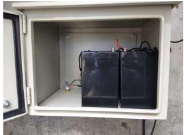
Después del mantenimiento
