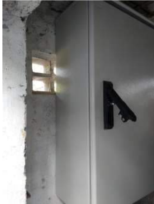
Después del mantenimiento
