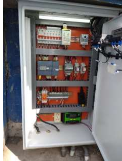
Después del mantenimiento
