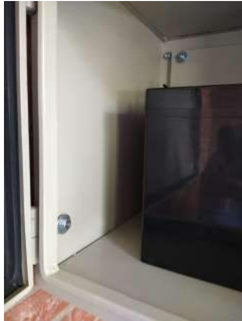
Después del mantenimiento
