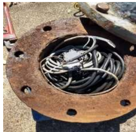
Después de mantenimiento
