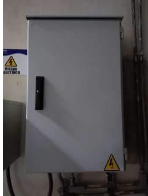
Después del mantenimiento
