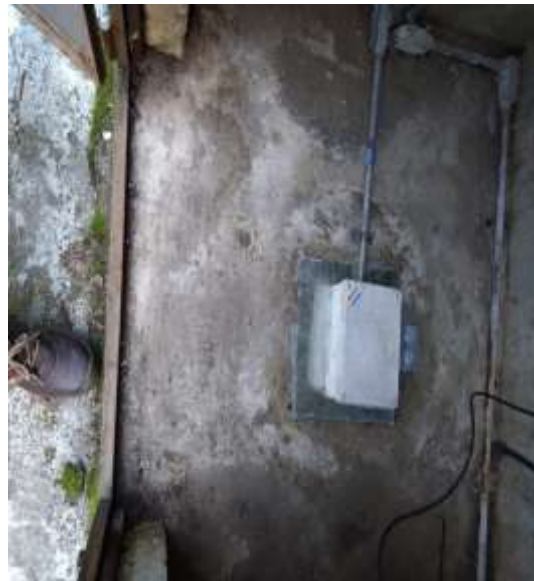
Después del mantenimiento
