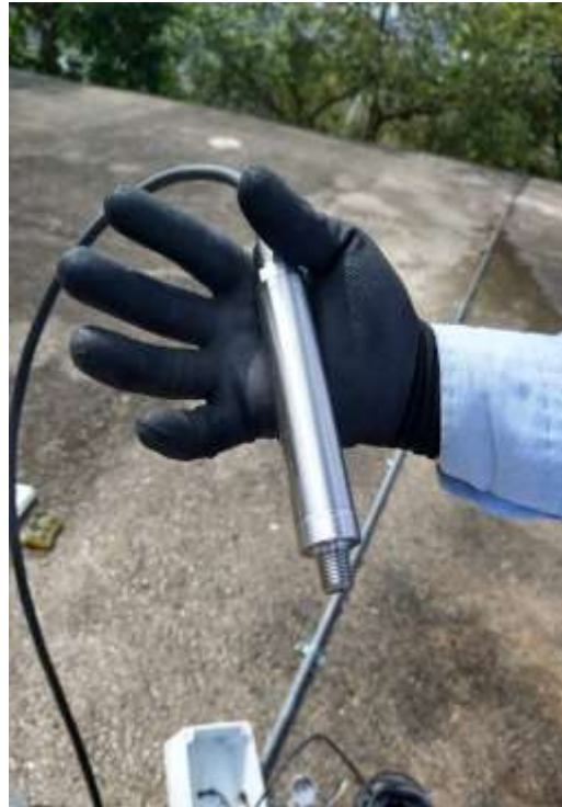
Después del mantenimiento
