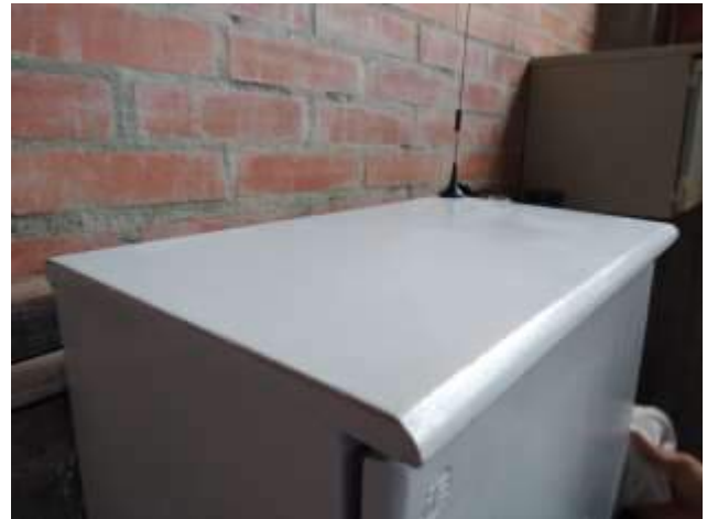
Después del mantenimiento
