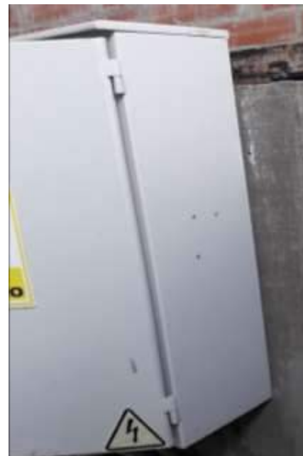
Después del mantenimiento
