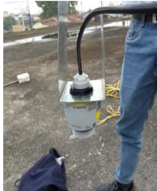
Después del mantenimiento
