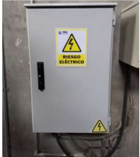
Después del mantenimiento
