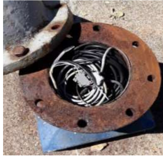
Después del mantenimiento
