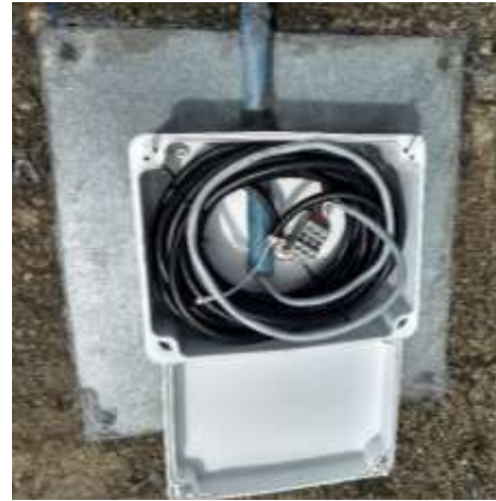
Después del mantenimiento
