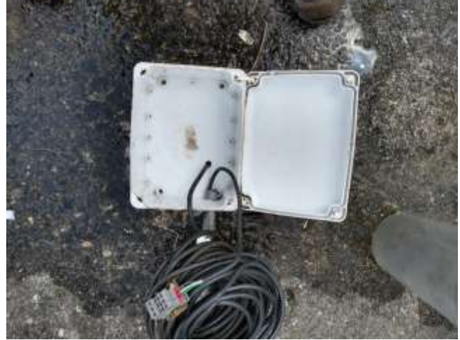
Después del mantenimiento
