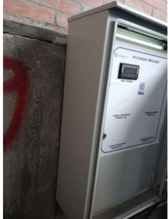
Después del mantenimiento
