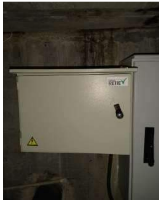
Después del mantenimiento
