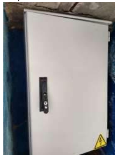
Después del mantenimiento
