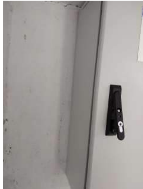
Después del mantenimiento
