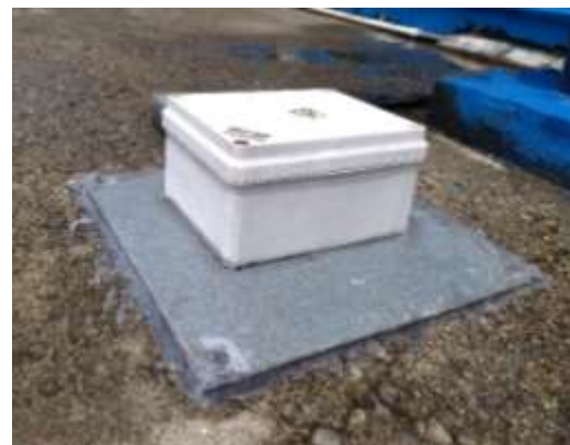
Después de mantenimiento
