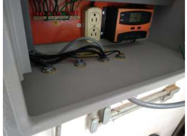
Después del mantenimiento
