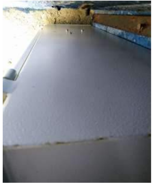
Después del mantenimiento
