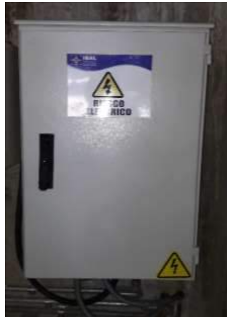
Después del mantenimiento
