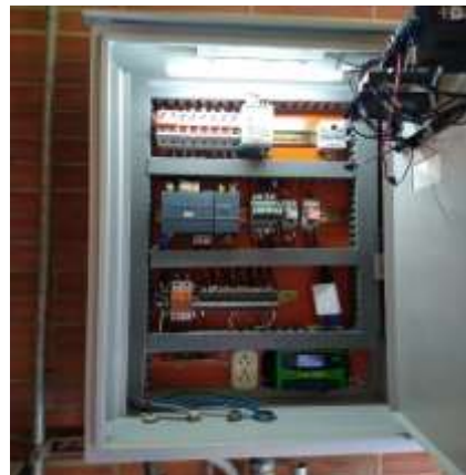
Después del mantenimiento
