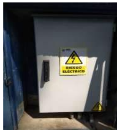
Después del mantenimiento
