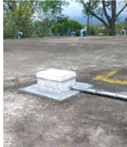
Después de mantenimiento
