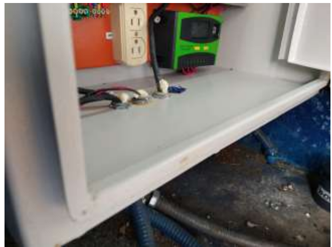
Después del mantenimiento
