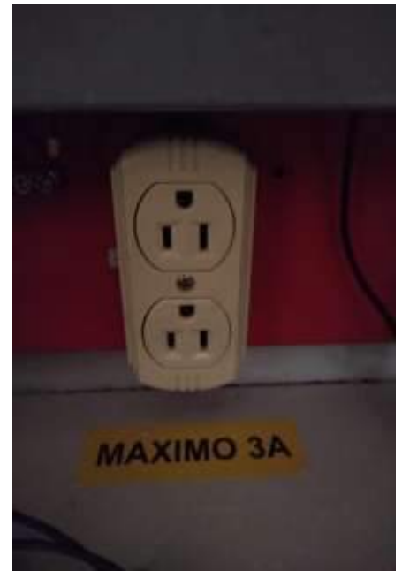
Después del mantenimiento
