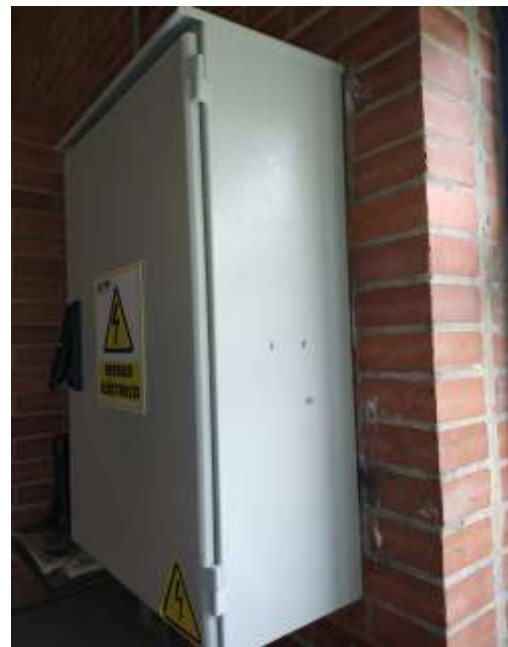
Después del mantenimiento
