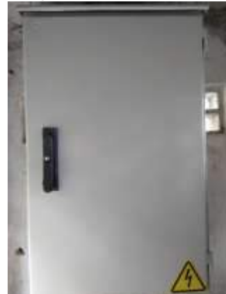
Después del mantenimiento
