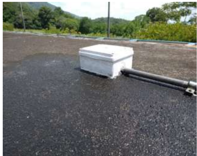
Después de mantenimiento
