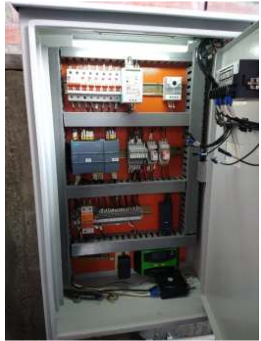
Después del mantenimiento
