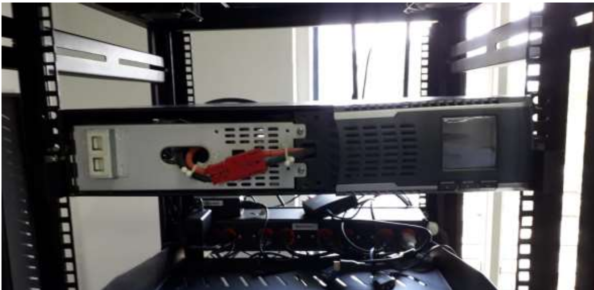
ESTADO FINAL DE LIMPIEZA DE UPS
