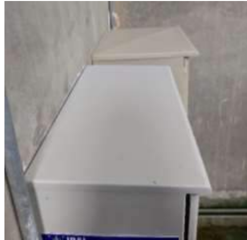
Después del mantenimiento
