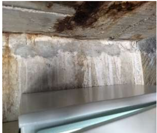
Después del mantenimiento
