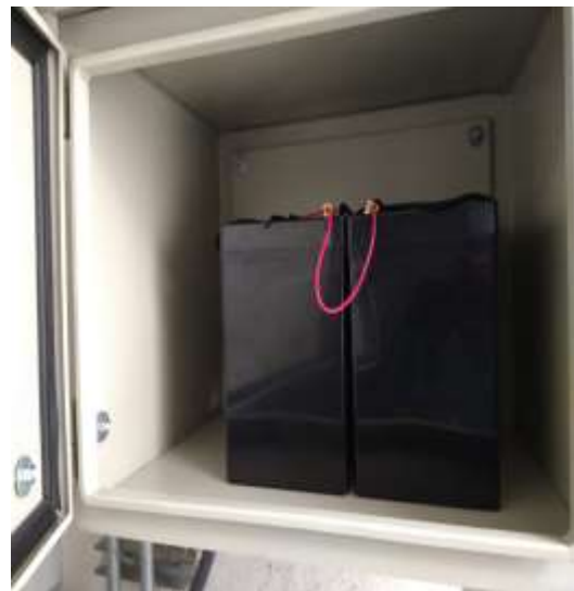
Después del mantenimiento
