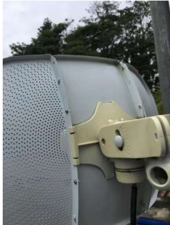
Después del mantenimiento
