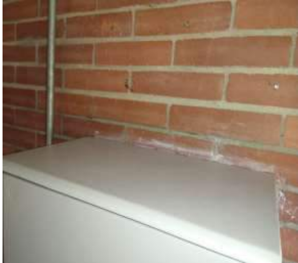
Después del mantenimiento
