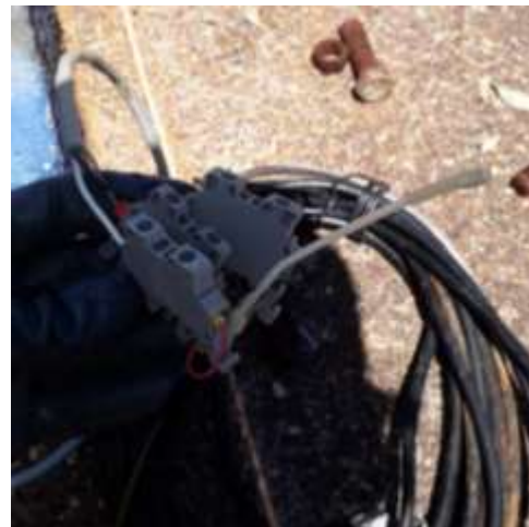
Después de mantenimiento
