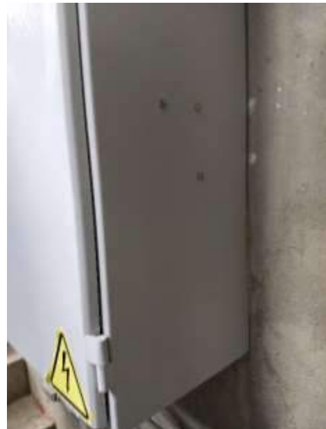
Después del mantenimiento
