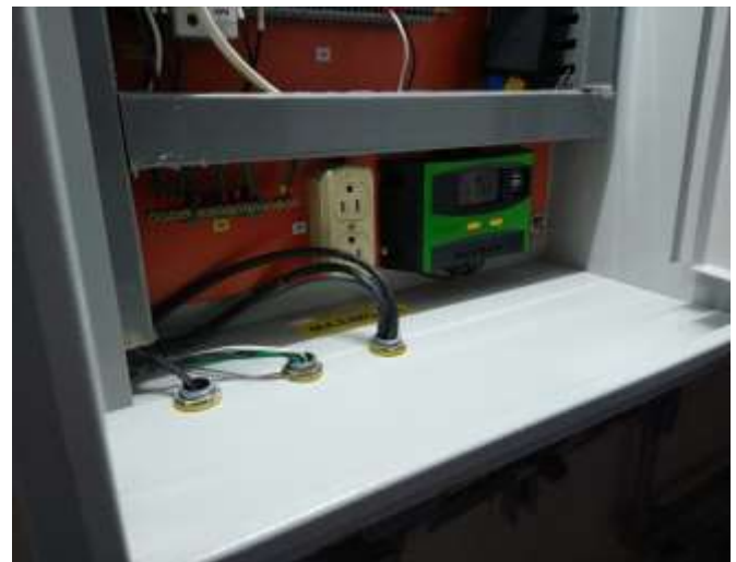
Después del mantenimiento
