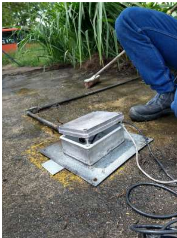
Después de mantenimiento
