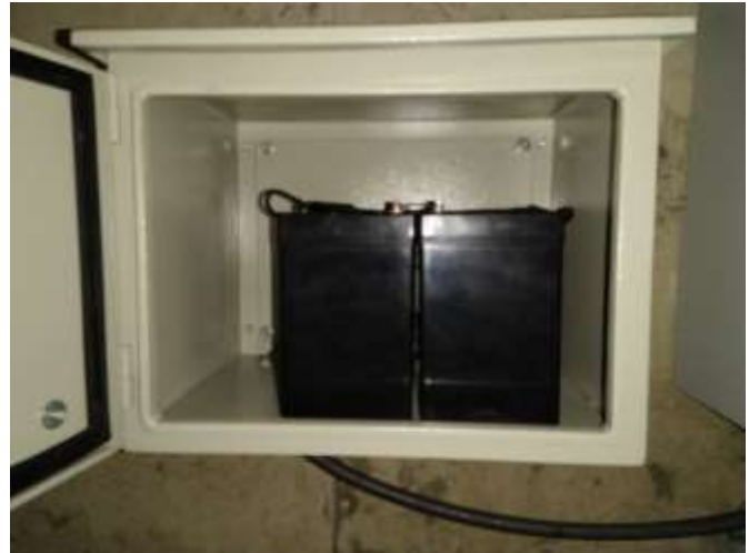
Después del mantenimiento
