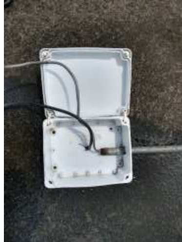
Después del mantenimiento
