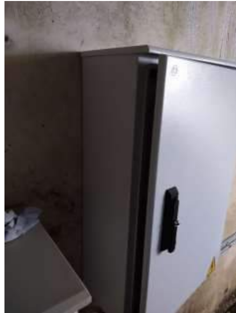
Después del mantenimiento
