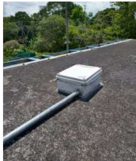
Después de mantenimiento
