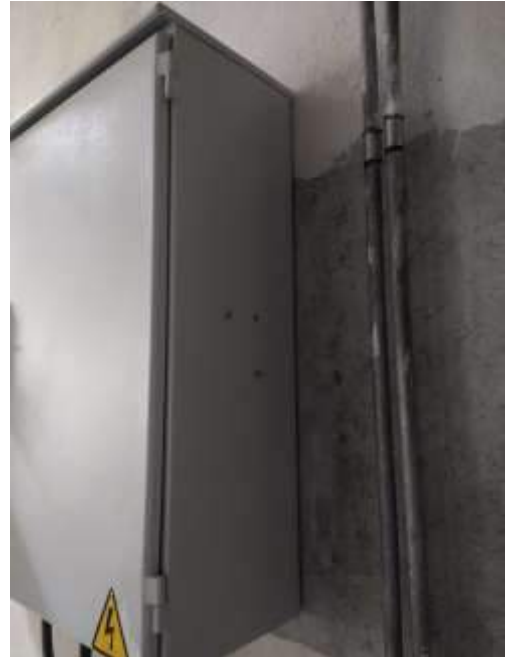
Después del mantenimiento
