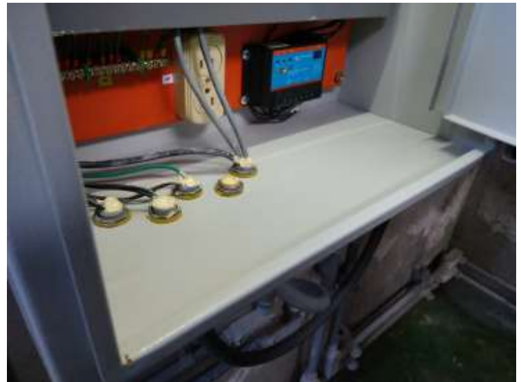
Después del mantenimiento
