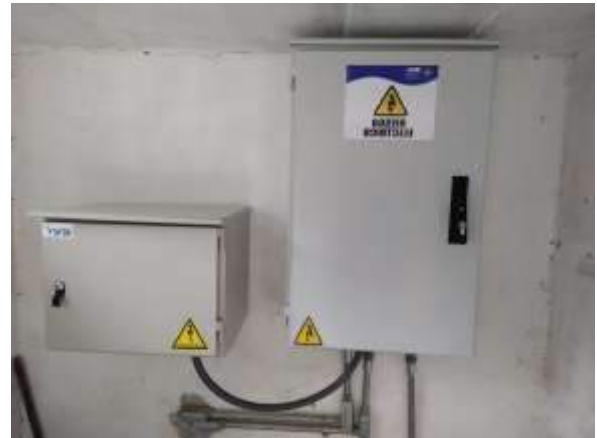
Después del mantenimiento
