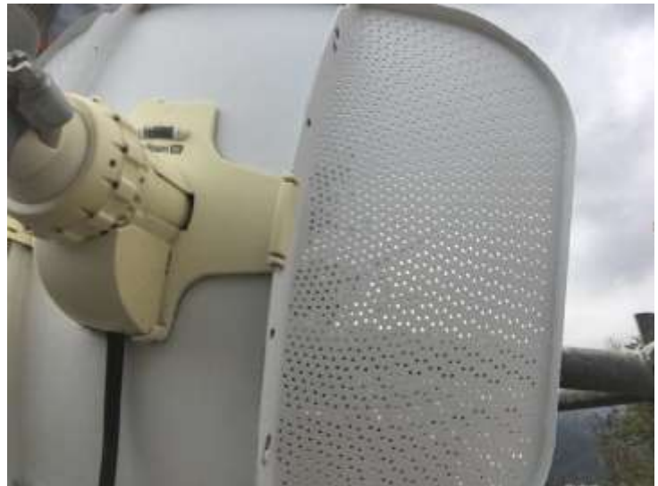
Después del mantenimiento
