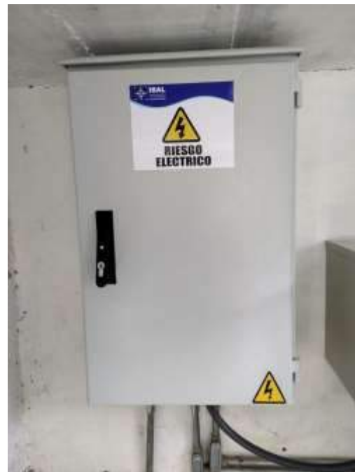
Después del mantenimiento
