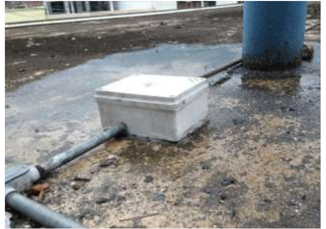
Después de mantenimiento
