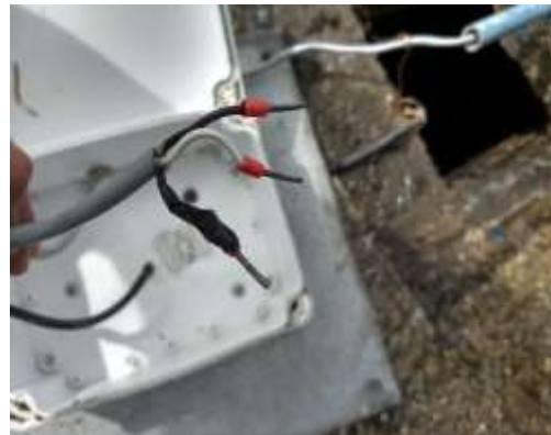
Después de mantenimiento
