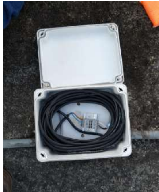
Después de mantenimiento
