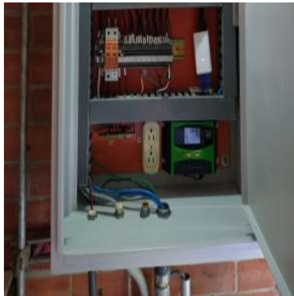
Después del mantenimiento
