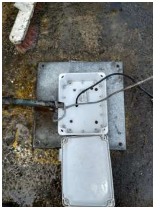
Después de mantenimiento
