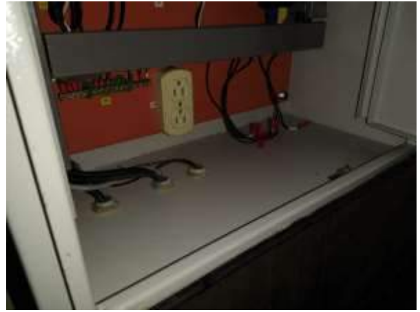
Después del mantenimiento
