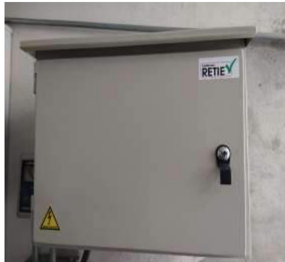
Después del mantenimiento
