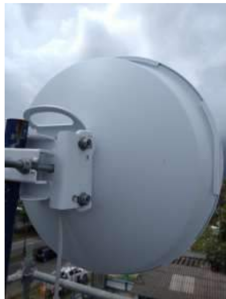
Después del mantenimiento
