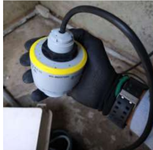
Después del mantenimiento
