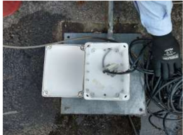
Después del mantenimiento
