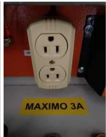
Después del mantenimiento
