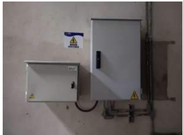
Después del mantenimiento
