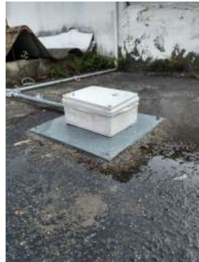
Después de mantenimiento
