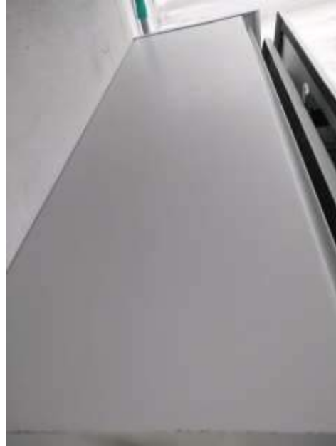
Después del mantenimiento
