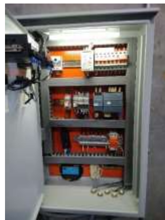
Después del mantenimiento
