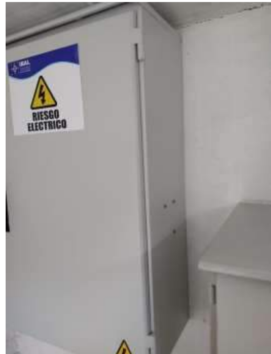
Después del mantenimiento
