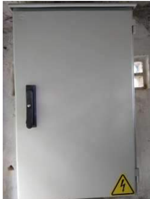
Después del mantenimiento
