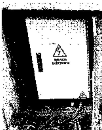
Antes del mantenimiento
