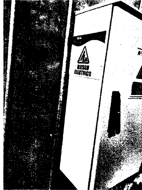
Después del mantenimiento
