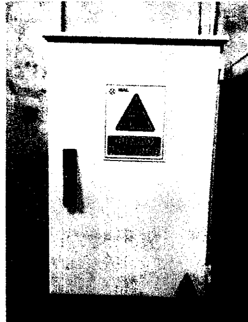
Después del mantenimiento
