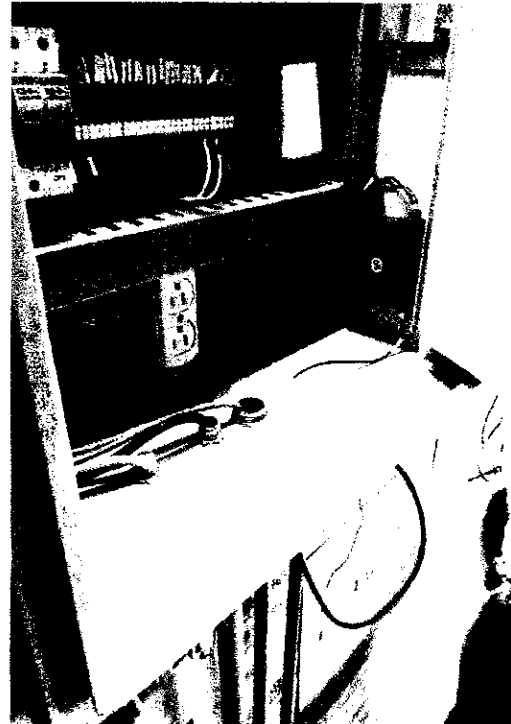
Después del mantenimiento
