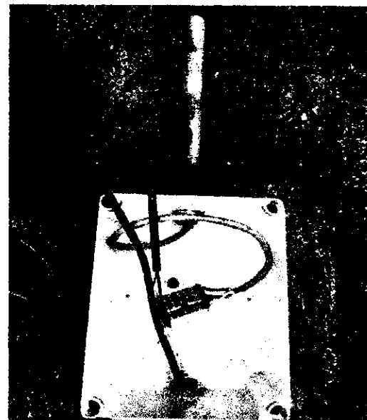
Después del mantenimiento
