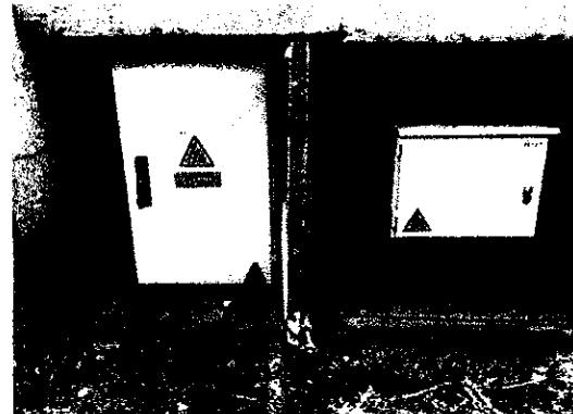
Después del mantenimiento
