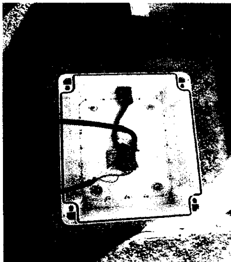
Después del mantenimiento
