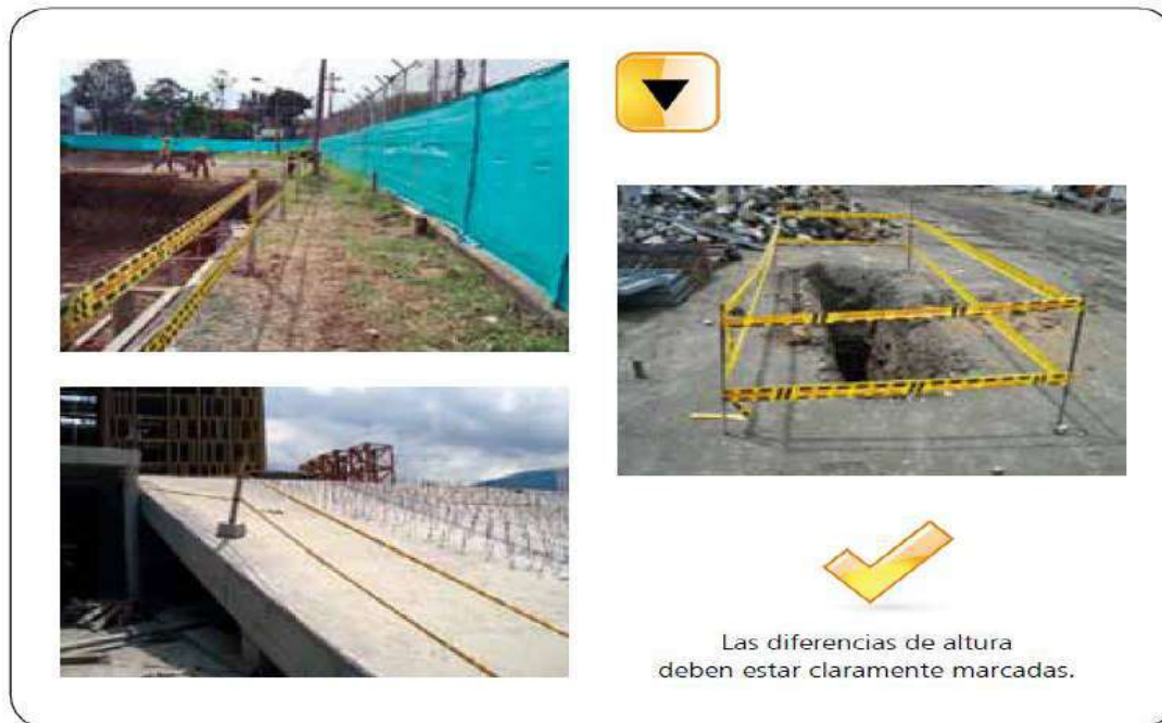
Figura 30. Manejo adecuado de la señalización
