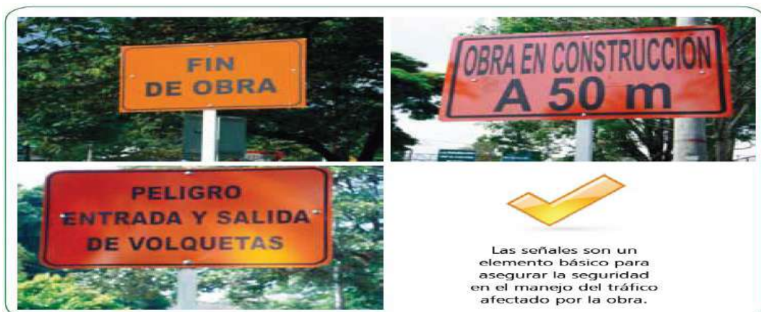
Figura 28. Manejo adecuado de la señalización
