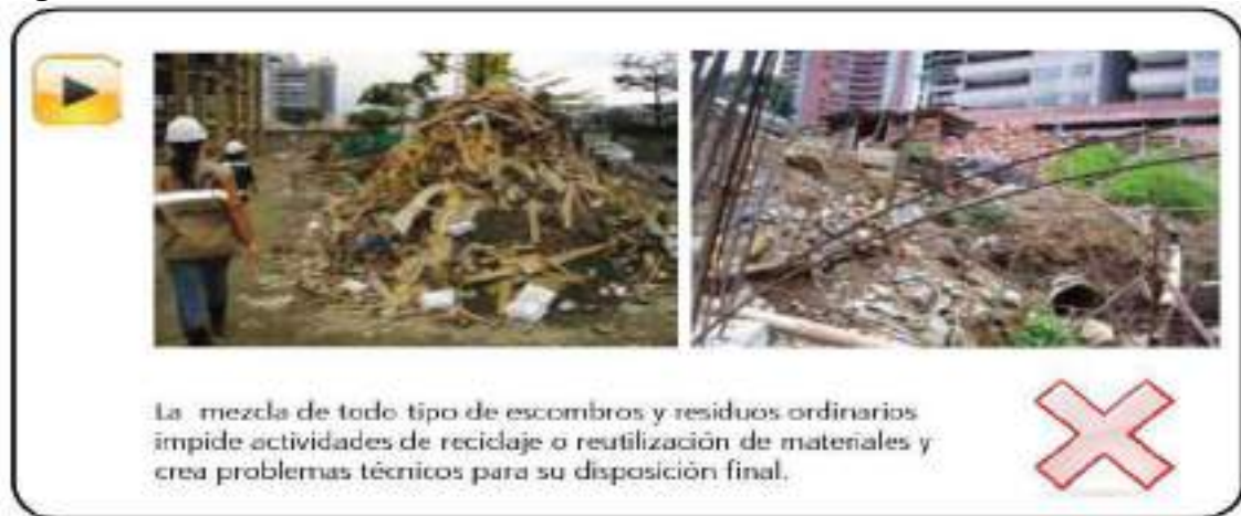
Figura 6. Inadecuada clasificación de residuos
