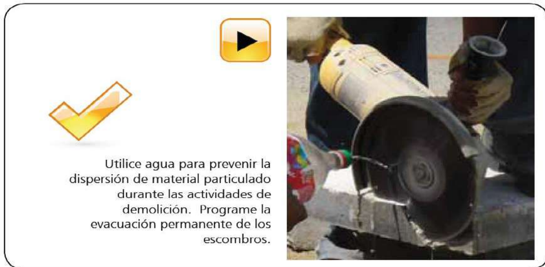
Figura 11. Manejo adecuado de partículas en el área de la obra
