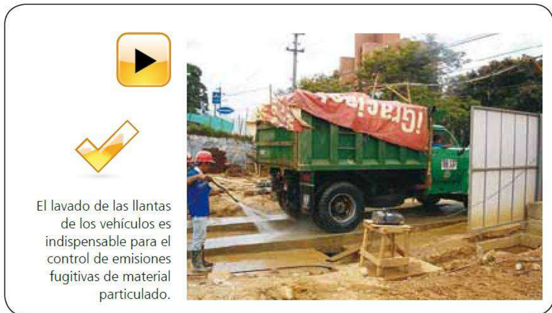
Figura 8. Manejo adecuado de partículas en el área de la obra
